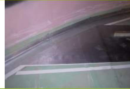
Herstellung der Doppelwand Überprüfung der ersten Schicht auf Mikrolöcher, Herstellung eines Spaltes mit Aluminium
