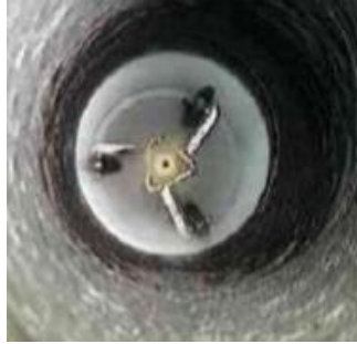
Reinigung und Sichtprüfung mit Roboter
