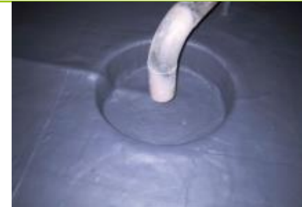
Herstellung der Doppelwand Doppelwand mit Anwendung von Laminat, erster Schicht und leitfähiger Oberschicht
