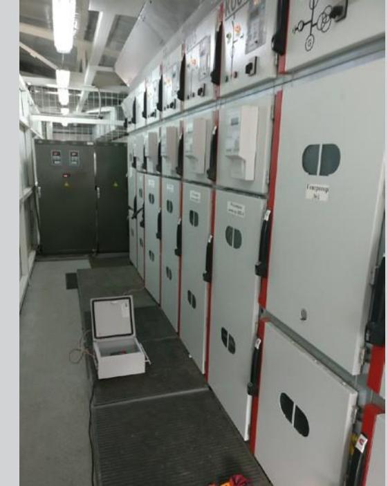
Ispitivanje funkcionalnosti sistema u uslovima prisustva visokonaponskog električnog luka.
